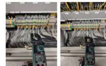
บำรุงรักษาเครื่องจักร วัดอัตราการใช้กระแสไฟฟ้าได้ 2.92-3.31 A อยู่ในเกณฑ์ปกติ
