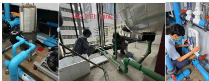
ภาพที่ 3-46 ตรวจสอบถังสำรองน้ำ ว่าล้นน้ำ ไม่มีจุดรั่วซึม
