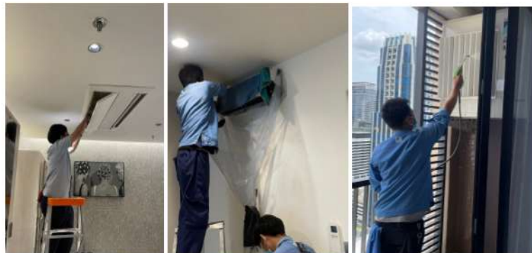
ภาพที่ 3-44 ทำความสะอาดเครื่องปรับอากาศส่วนกลางประจำอาคาร
