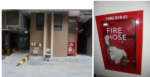
ภาพที่ 3-21 ท่อขึ้นและตู้เก็บสายขึ้นน้ำดับเพลิงพร้อมอุปกรณ์
