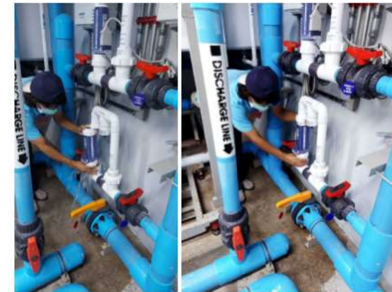
ภาพที่ 3-40 ตรวจสอบดูและระบบประปา ไม่มีรั่วซึม
