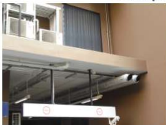
ภาพที่ 3-17 ท่อไอเสียจากห้องไฟฟ้าฉุกเฉิน ปลดปล่อยมาตรงกับต้นไม้ยืนต้นข้างรั้วโครงการ
