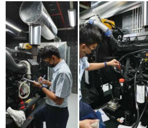
ภาพที่ 3-47 ตรวจสอบและบำรุงรักษาระบบไฟฟ้าสำรองฉุกเฉิน
