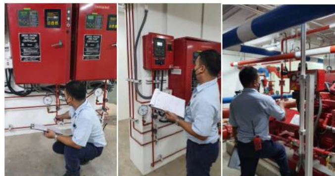
ภาพที่ 3-45 ตรวจสอบระบบป้องกันอัคคีภัยและเครื่องบิมน้ำดับเพลิง
